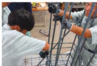
学校実習（鉄筋・型枠実習）
