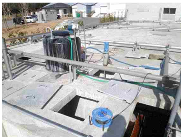
ポリ塩化アルミニウム添加高度処理装置
