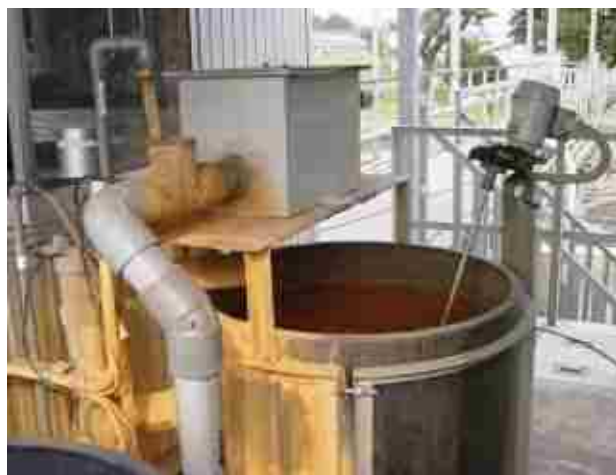
ポリ硫酸第二鉄添加高度処理装置
