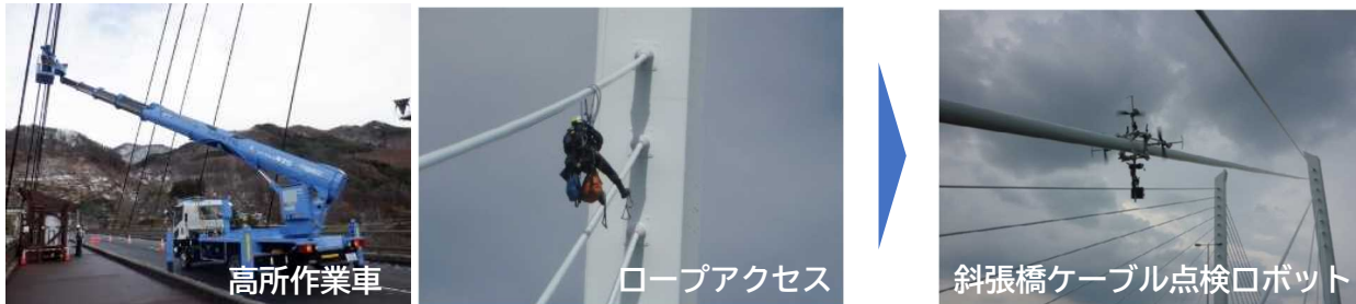
写真 2-1 従来点検と新技術(斜張橋ケーブル点検ロボット)を活用した点検の比較
