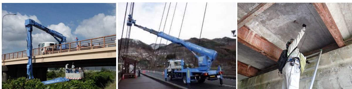
写真 1-3 橋梁点検の実施状況
