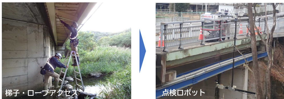
写真 2-2 従来点検と新技術(点検ロボット)を活用した点検の比較
