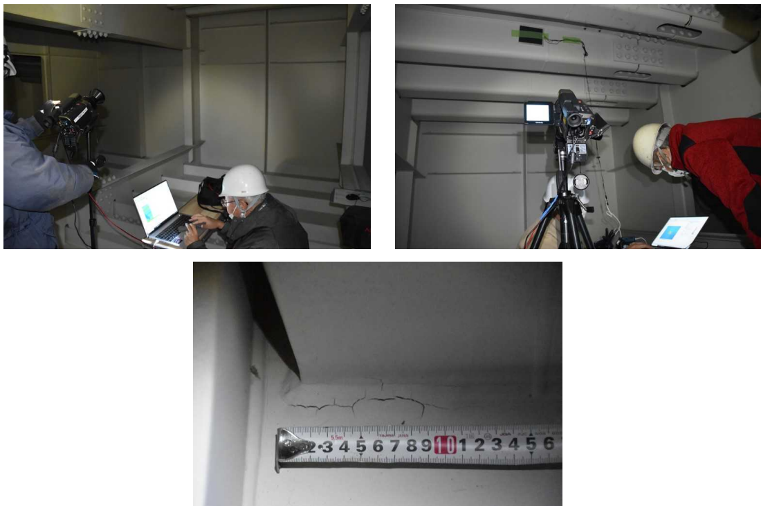
写真 2-4 県管理橋梁での実証実験実施状況
