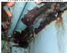
床版の腐食（断面欠損）
