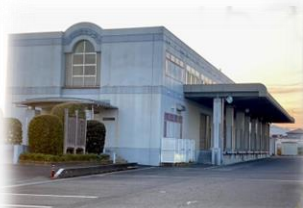
群馬県地域防災センター (大規模災害時の防災拠点)
