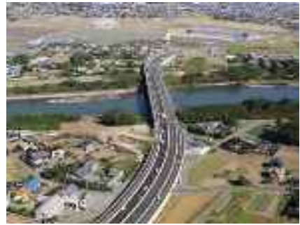
東毛広域幹線道路（国道354号）
