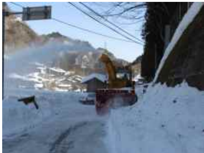
南牧村孤立対策の除雪状況
