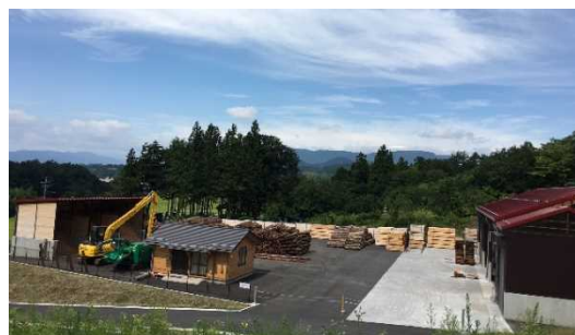
ウッドビレジ川場製材工場
