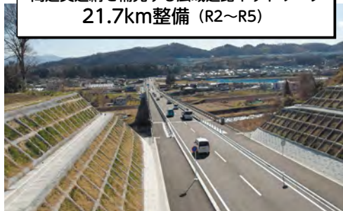
▲ 西毛広域幹線道路（高崎西工区） ▲
