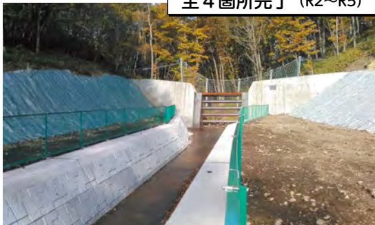
▲ 女塩淵沢 土石流対策 ▲
