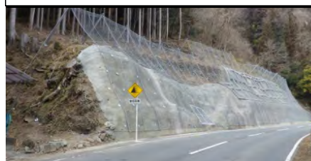
▲ 国道462号 (生利工区) 落石対策 ▲
