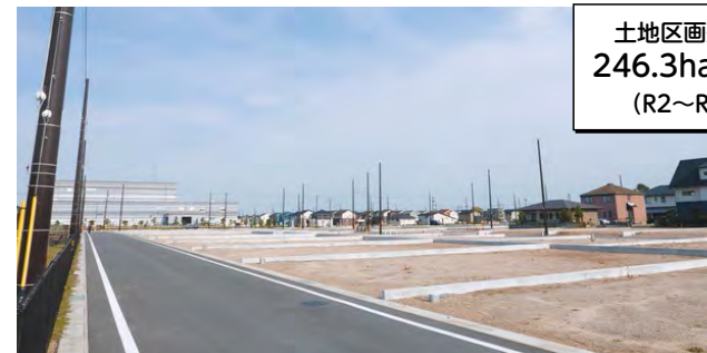
新規住宅地の造成状況
