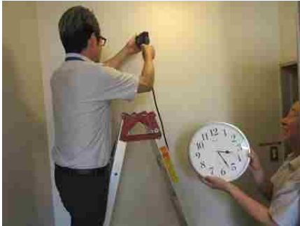
脱衣所の壁掛時計取付作業
