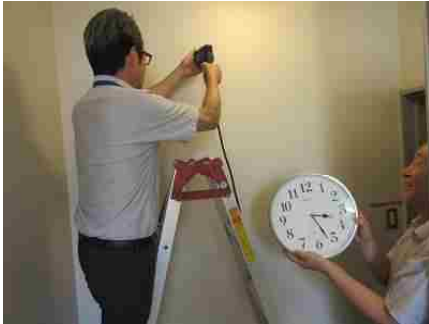
脱衣所の壁掛時計取付作業
