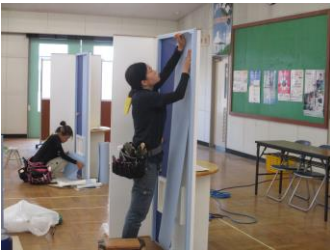
技能検定（内装仕上げ施工）
