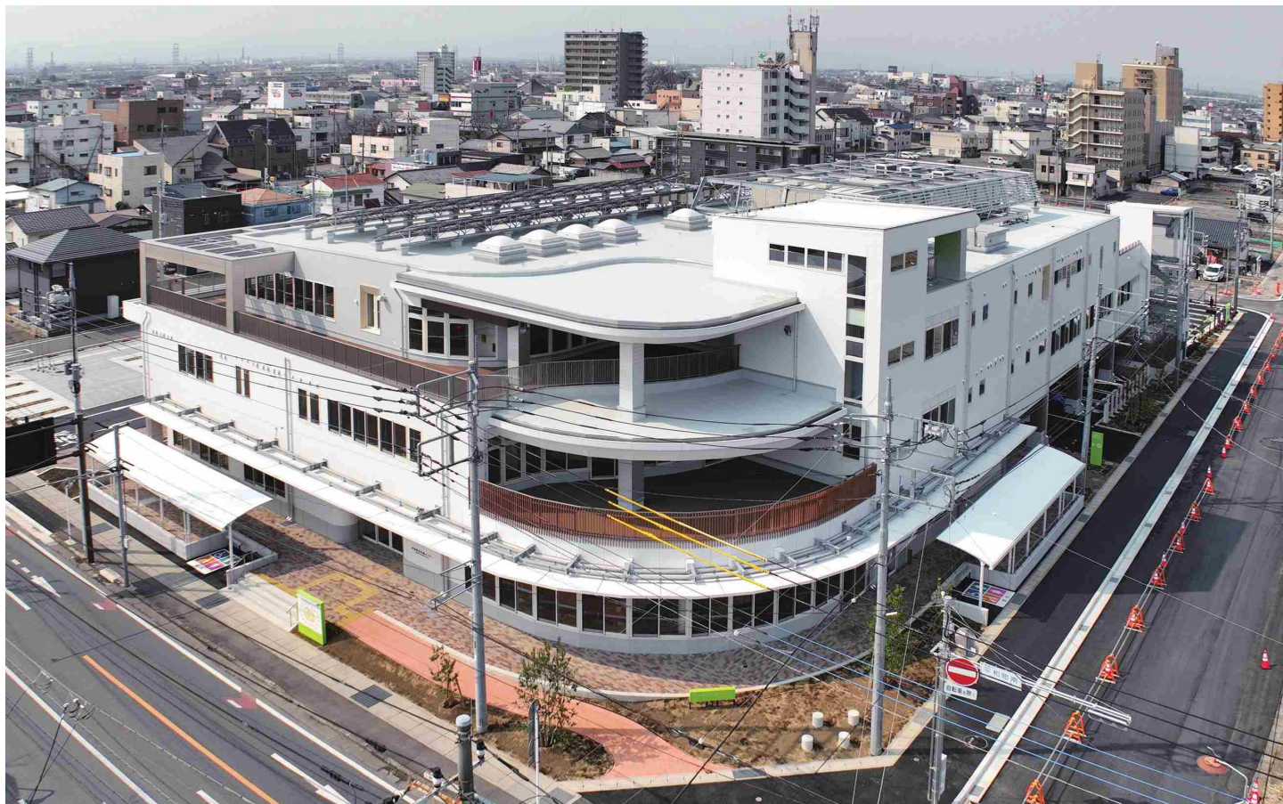
新たに建設された伊勢崎市の保健センター
