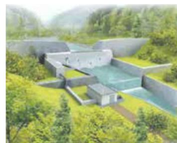
既存の砂防堰堤を利用した小水力発電(イメージ)。新たなダムや貯水池の建設が不要で、環境負荷が少ない
