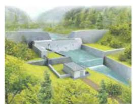
既存の砂防堰堤を利用した小水力発電(イメージ)。新たなダムや貯水池の建設が不要で、環境負荷が少ない
