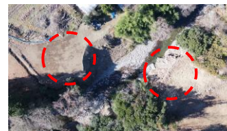
（仮称）黒石1号橋下部工箇所
