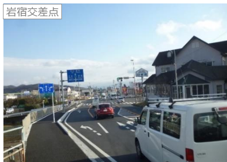
事業後の状況（一部完了区間）
