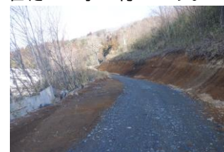
工事用道路整備完了
