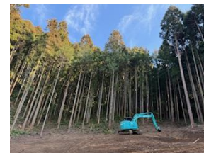
砂防堰堤の整備着手
