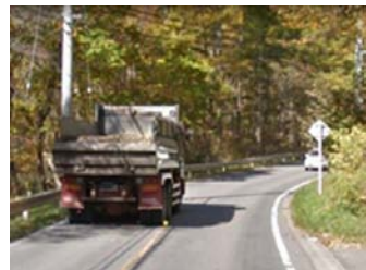
国道144号幅員狭小状況
