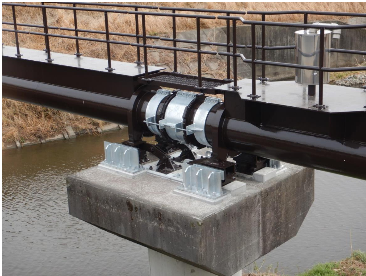
県央第二水道事務所 水管橋落橋防止装置
