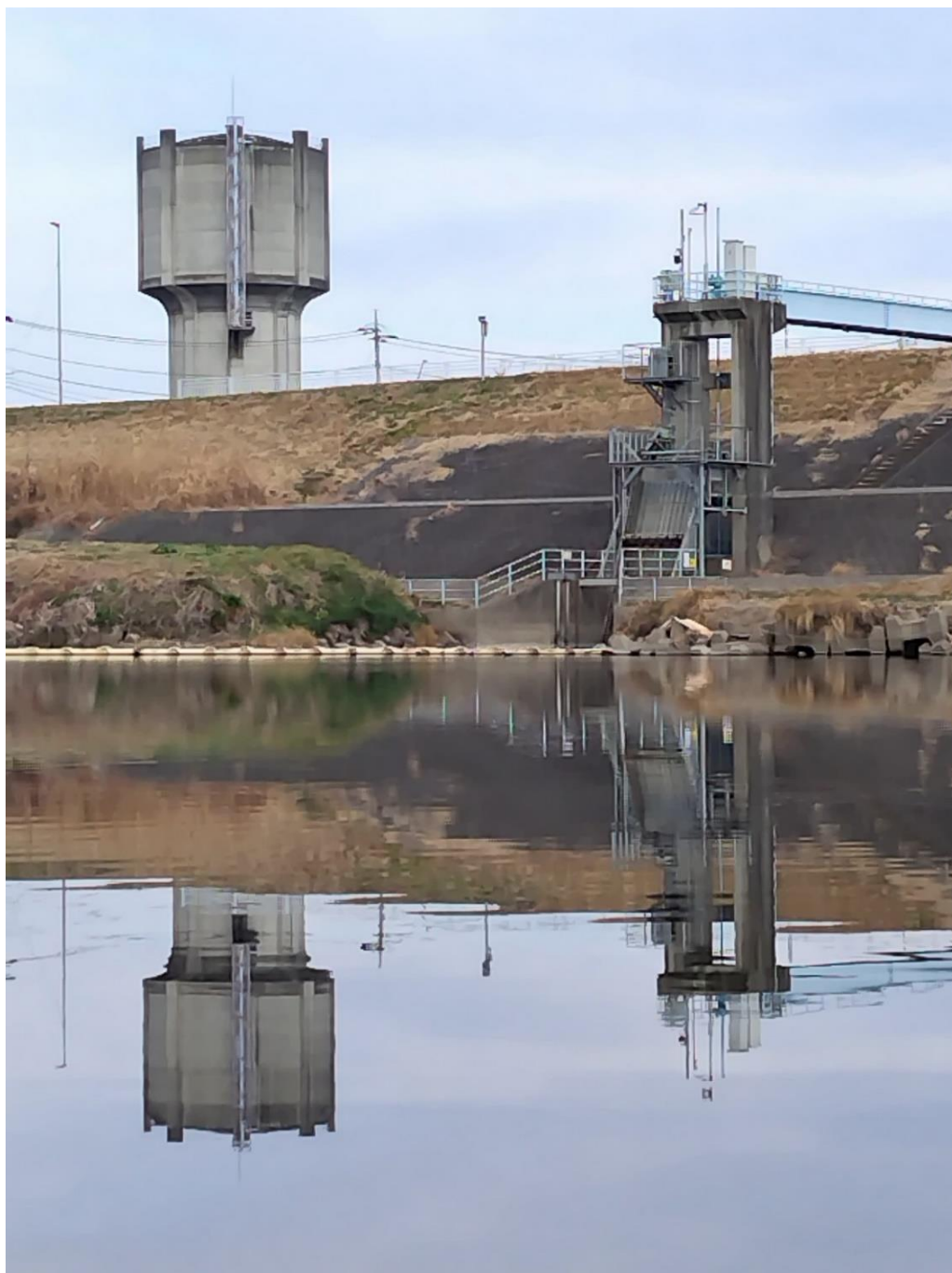
東毛工業用水道事務所 高架水槽と取水口
