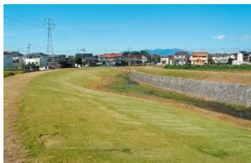
緩傾斜護岸(男井戸川 伊勢崎市)
