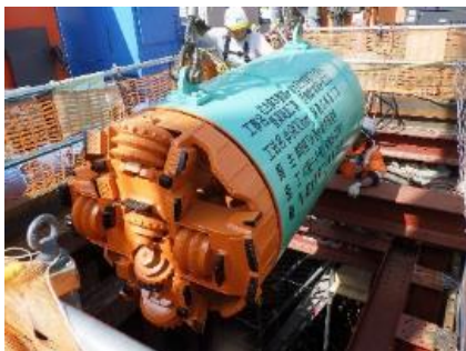
管渠整備 施工状況
