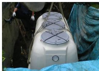
合併処理浄化槽 施工状況
