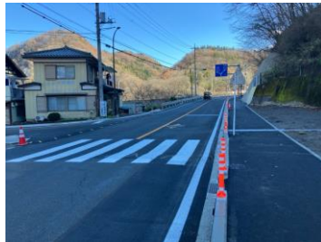
現道拡幅の整備状況
