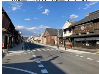
無電柱化事業の事例
