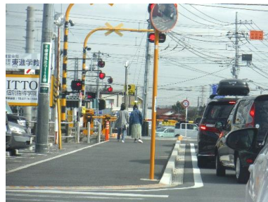
完了区間状況
