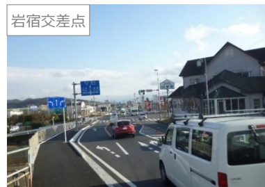
完了区間状況
