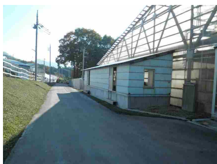
密閉型堆肥舎に設置
