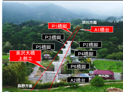
泉沢大橋 施工状況 (R7.5撮影)
