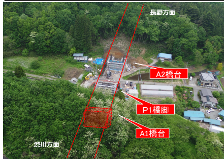
上信小泉橋 施工状況 (R7.5撮影)
