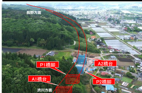
西沢橋 施工状況 (R7.5撮影)
