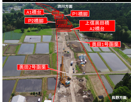
奥田地区 施工状況 (R7.5撮影)
