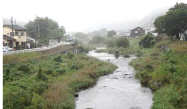
図-2.4 大堰頭首工 (農業用水)
