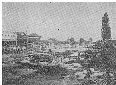
桐生市境野町地内（家屋倒壊）※
