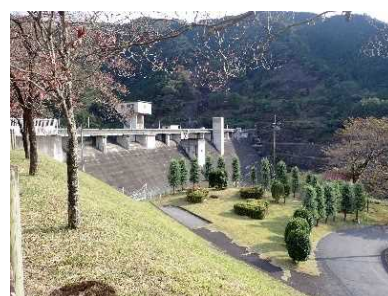
図-2.5 桐生川ダム (発電用水・農業用水・水道用水等)
