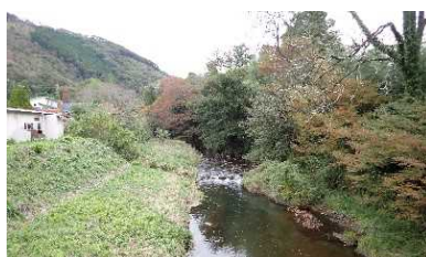
図-2.20 桐生川（観音橋）
