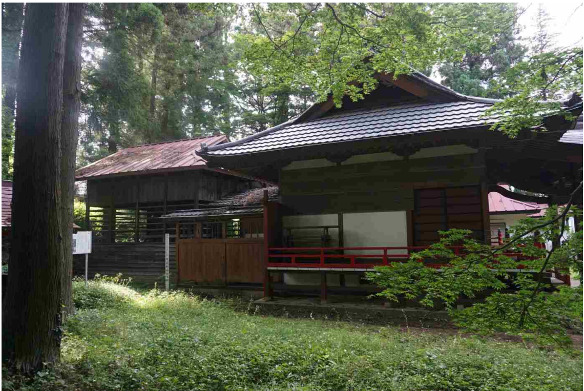
【参考】本殿覆屋（左側）及び拝殿（右側）
