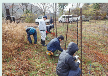
金網設置作業の様子
