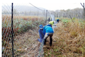
植生保護柵の作業状況
