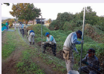
金網設置作業のようす
