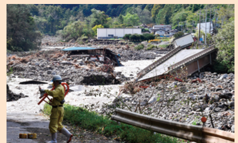
令和元年10月に発生した台風19号の影響により、吾妻川に崩落した国道144号線(婦恋村) 写真提供：上毛新聞社
