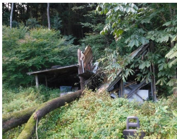
④ 平成30年9月 台風24号により倒木(川浦)
