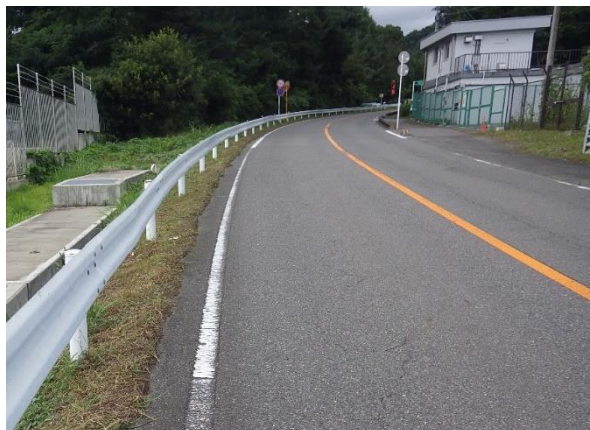
道路の除草状況（前橋赤城線）
