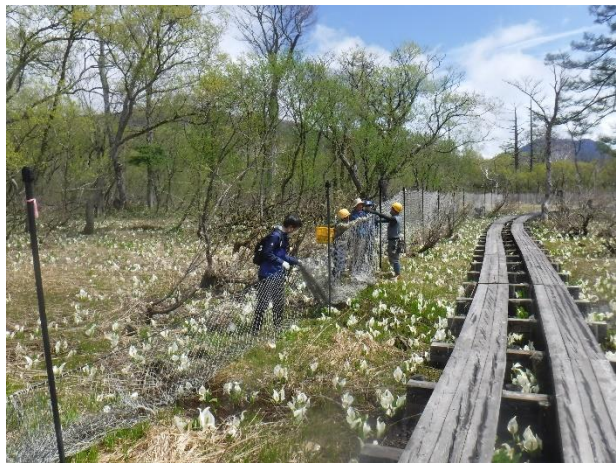
保護柵設置の様子
