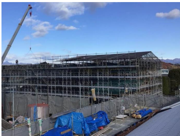
富岡製糸場乾燥場整備工事 (画像提供：富岡市)
