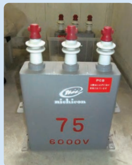
電力用コンデンサー
