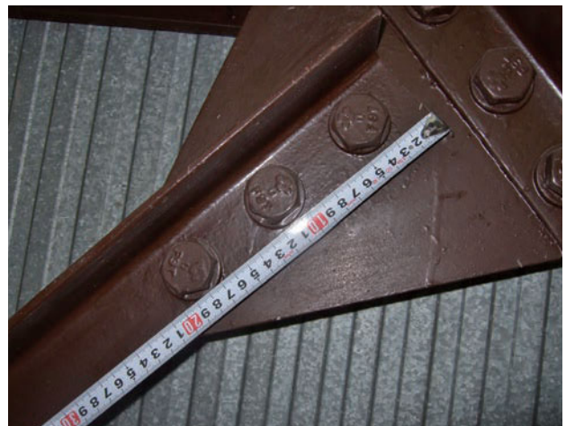
ブレース接合部調査
