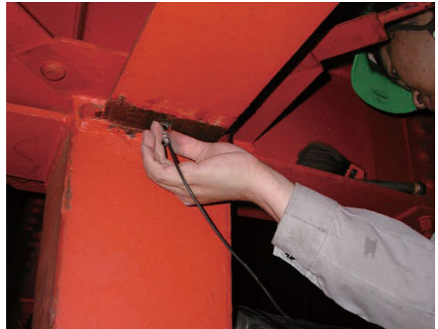
溶接接合部調査(UT試験状況)
