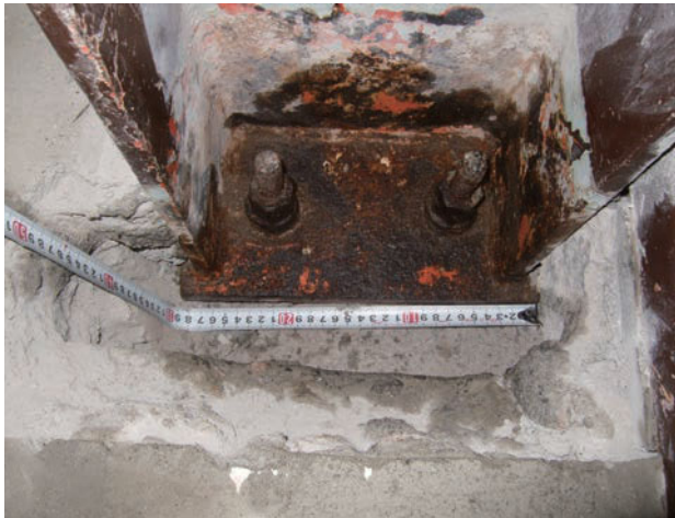
柱脚部調査(接合、発錆状況)
