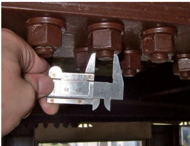
高力ボルト径測定調査
