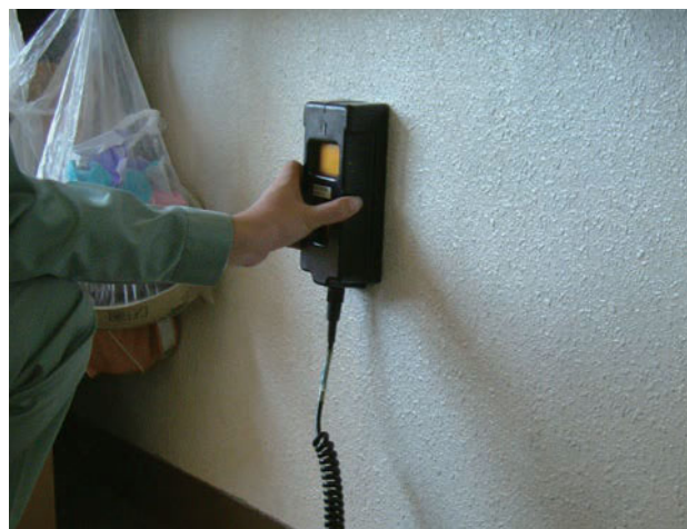
配筋調査(鉄筋探査状況)
