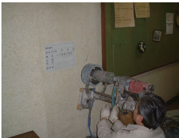
コンクリートコア抜き状況
