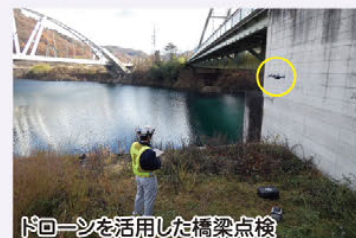
ドローンを活用した橋梁点検
