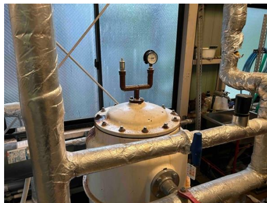
山中温泉の近世より続く老舗旅館「たわらや」の機械室（左がメイン、右がサブ）。左の写真の左端にある銀色のタンクと右の写真の真ん中のタンクが循環濾過槽。左の写真の左下のタンクに塩素が入っている。
