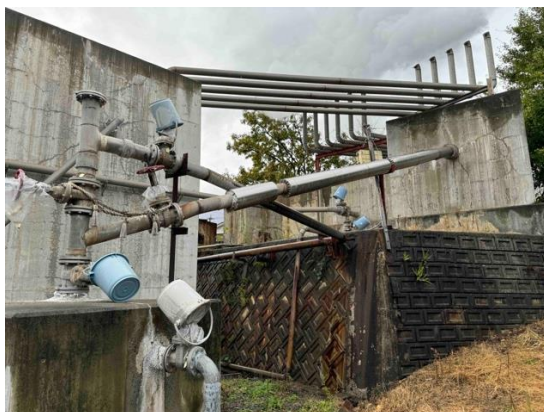
別府鉄輪温泉「ひょうたん温泉」のセパレーター。高圧の温泉が温泉水と蒸気に分離される。右上のパイプから、分離された蒸気の一部が湯けむりとして出てきている。
