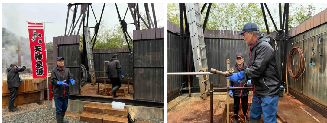
有馬温泉の天神泉源のメンテナンスの様子。スケールが極めて多いためケーシングをかなりの頻度で交換する必要があるが、交換作業は、高圧・高温の湯が噴き出してくるため、極めて危険であり、長年の経験に裏打ちされた感覚が必要とされる。
