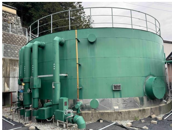
下呂温泉の集中管理システムを支える4つのポンプ所の一つ、温泉寺ポンプ所の貯湯タンク。ここから下呂温泉の各旅館へと送湯される。
