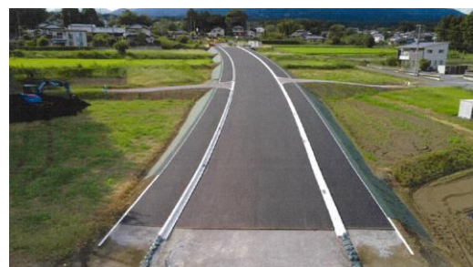
4期工区の様子 (完成区間)
