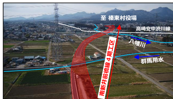
終点（東）から起点（西）を望む（R6.3時点）
