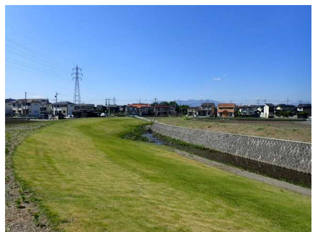
緩傾斜護岸を整備
