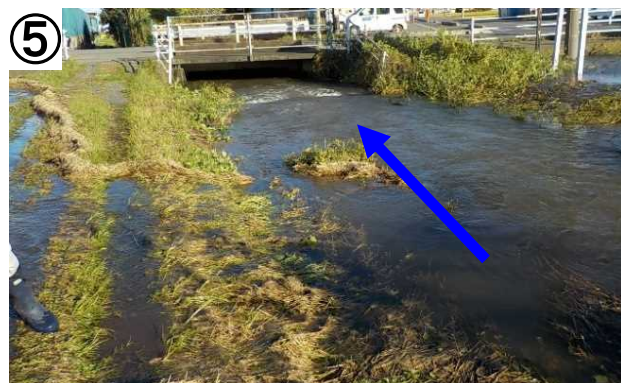
平成29年台風21号 浸水状況
