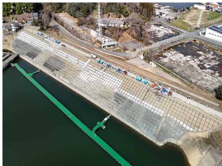
R6年度 大谷池 上流側堤体補強盛土
