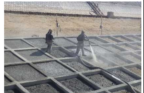
法枠工(吹付工)の施工状況
