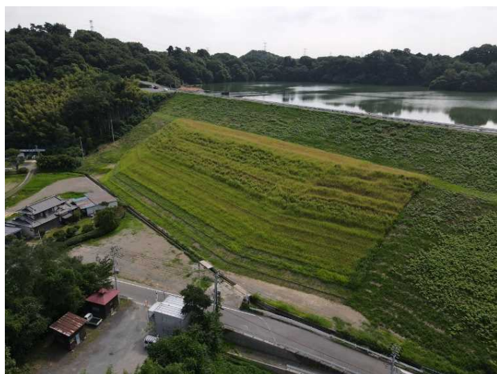
R2年度 牛秣貯水池 下流側堤体補強盛土
