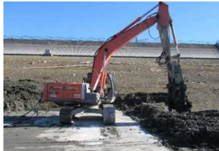
地盤改良工の実施状況
