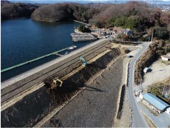
植物に配慮した表土戻し作業
