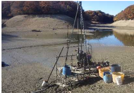
ボーリング調査の実施状況
