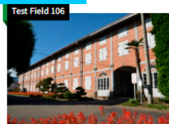
富岡製糸場 [富岡市]
