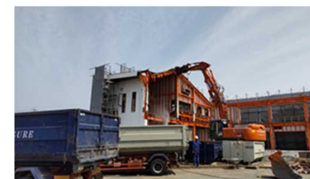
〔板倉ゴルフ場クラブハウス解体〕
