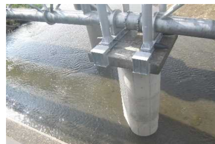
〔東毛工業用水道水管橋耐震化〕
