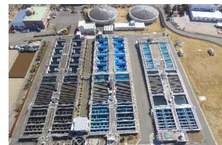
〔県央第一水道浄水場〕
