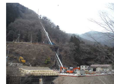
〔四万発電所リニューアル工事〕
