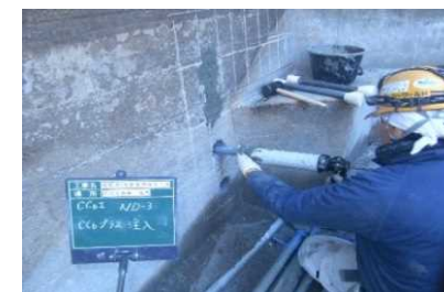
〔渋川工業用水道沈殿池補強〕
