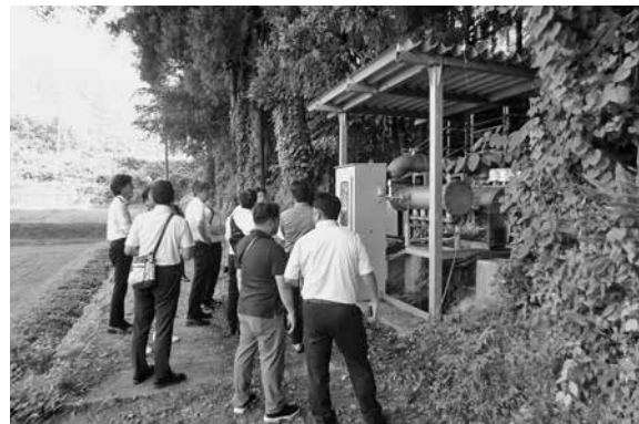
設備の説明を受ける様子
