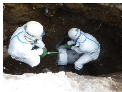
石綿セメント管の撤去状況
