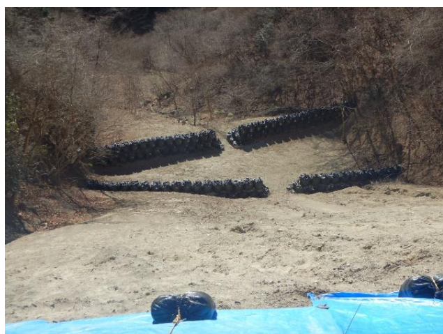
大型土のう設置状況（盛土の安定化、土砂の流出防止対策） 大型土のうは、1袋あたり1.6～2.0トンほどあります。
