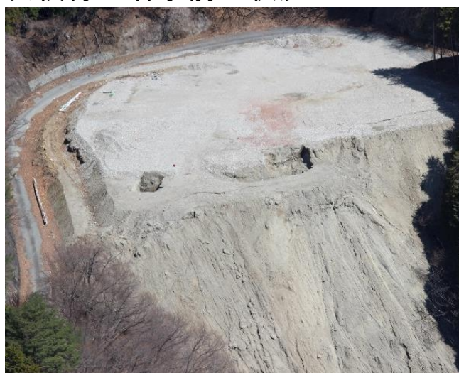
安定しない盛土のため亀裂が多く、豪雨時には浸食による流出が見受けられました。
