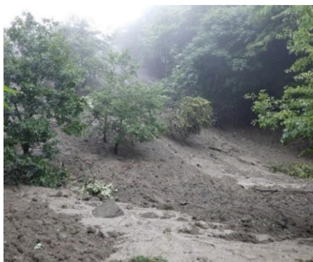
安定しない盛土のため亀裂が多く、豪雨時には浸食による流出が見受けられました。
