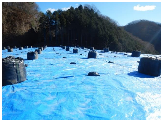
ブルーシート設置状況（雨水等の浸水防止） 風対策のため、小型土のうや大型土のうも設置しています。
