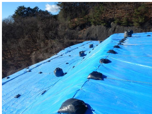
ブルーシート設置状況（雨水等の浸水防止） 風対策のため、小型土のうや大型土のうも設置しています。
