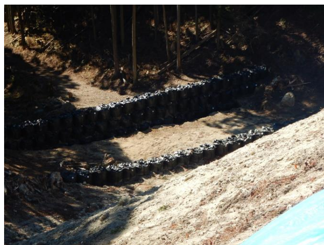
大型土のう設置状況（盛土の安定化、土砂の流出防止対策） 大型土のうは、1袋あたり1.6～2.0トンほどあります。
