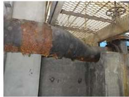
〔老朽化した送水ポンプ室内配管〕
