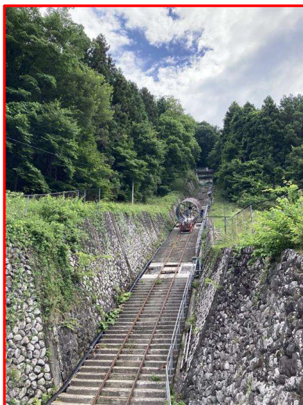
〔白沢発電所 水圧鉄管の据付〕
