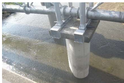
〔東毛工業用水道水管橋*耐震化〕
