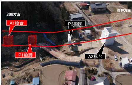
西沢橋 施工状況 (R8.2撮影)
