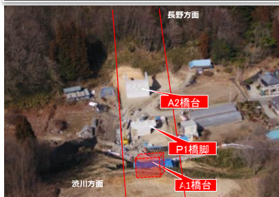
上信小泉橋 施工状況 (R8.2撮影)
