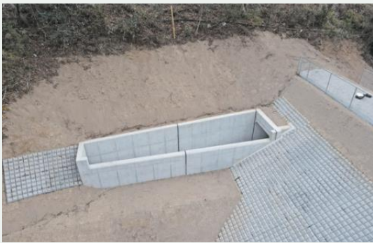
豪雨対策（洪水吐改修）
