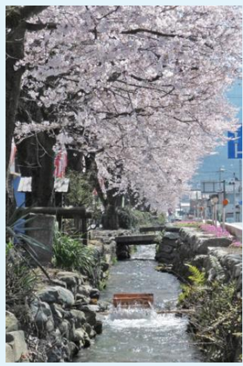
石積水路と桜の風景（雄川堰）
