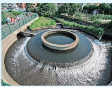
円筒分水工（長野堰用水）
