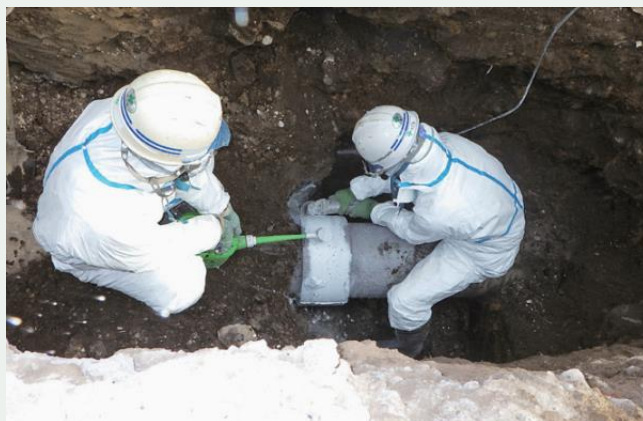
石綿（アスベスト）を含む農業用管水路を撤去し、硬質塩化ビニル管等へ更新
