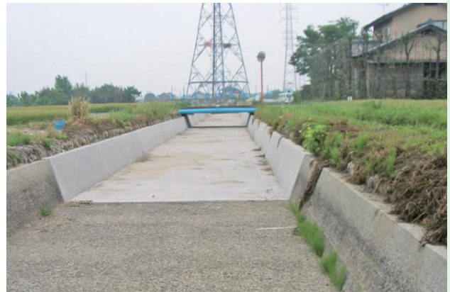
水路の補修（藤岡市：中村堰幹線水路）
