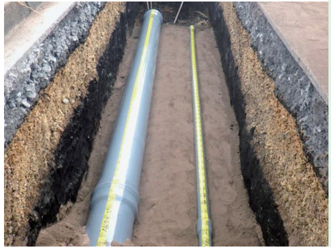
硬質塩化ビニル管への敷設替え状況（昭和村）
