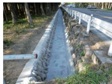
事業実施後（石積水路）
