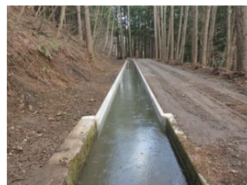
事業実施後（開水路）
