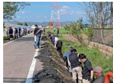
水路の泥上げ
