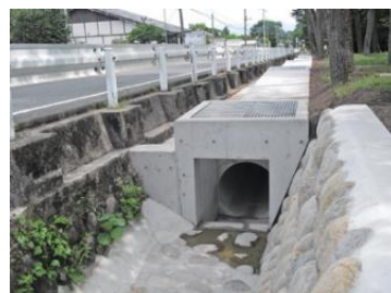
事業実施後（管渠）
