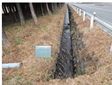
事業実施前（石積水路）
