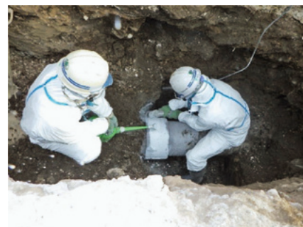
石綿セメント管の撤去状況
