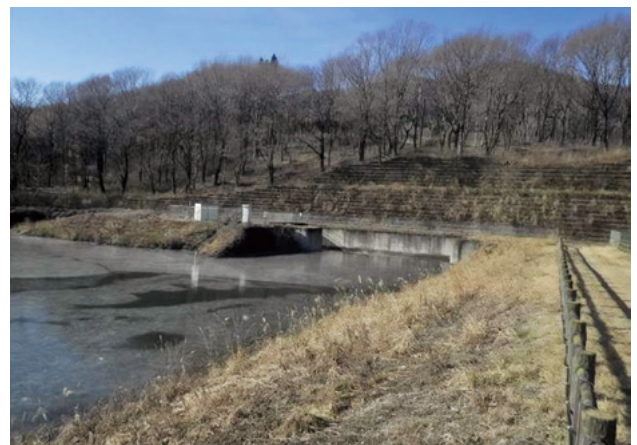
整備予定のため池
