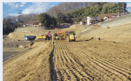
堤体の補強盛土工事（藤岡市 大谷池）
