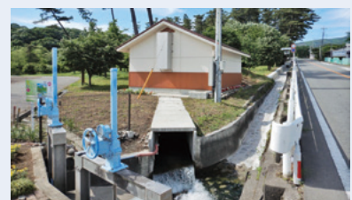
農業用水を活用した小水力発電施設 （赤城大沼用水（前橋市））
