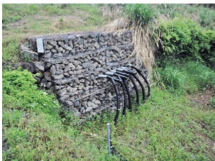
地すべり防止施設の長寿命化対策
