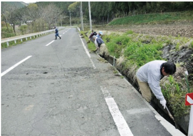
水路の泥上げ
