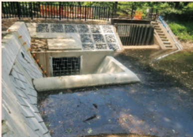
豪雨対策（洪水吐き改修）
