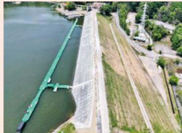
地震対策（押え盛土）
