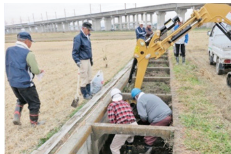
水路の泥上げ
