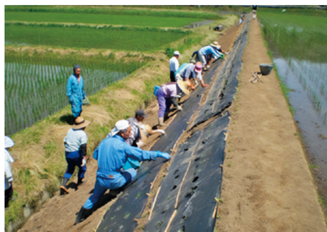
法面の保護・改修
