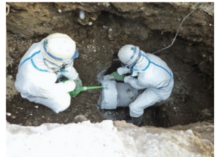
石綿セメント管の撤去状況
