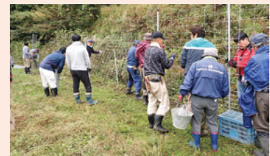
侵入防止柵の設置
