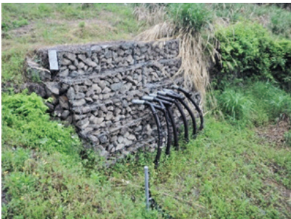
地すべり防止施設の長寿命化対策
