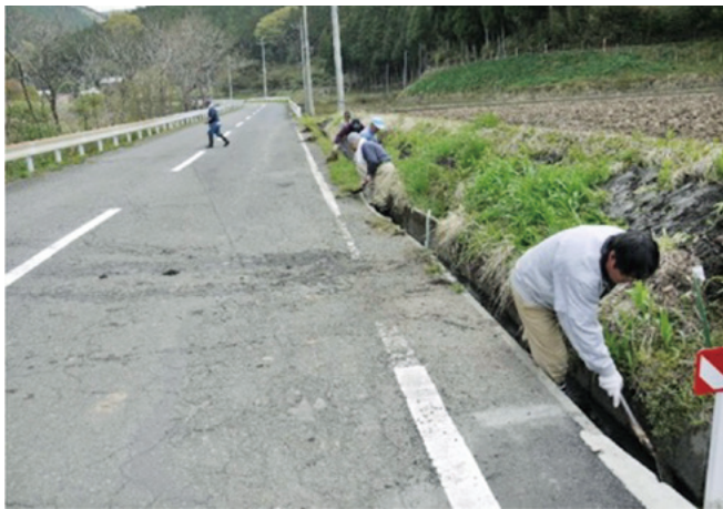
水路の泥上げ
