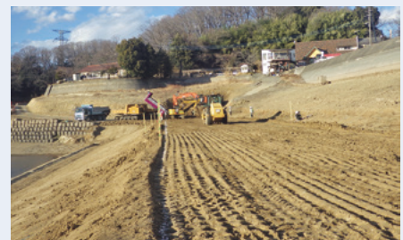
堤体の補強盛土工事（藤岡市 大谷池）
