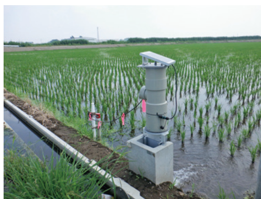
自動給水栓の実証（野辺地区）
