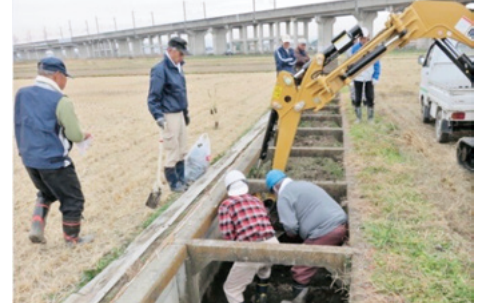
水路の泥上げ
