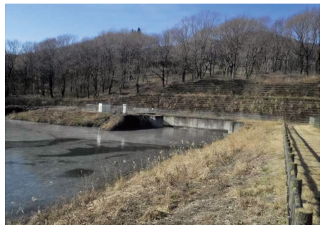
整備予定のため池
