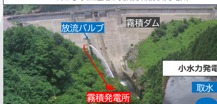
R7.7月から本格運用が開始した霧積発電所
