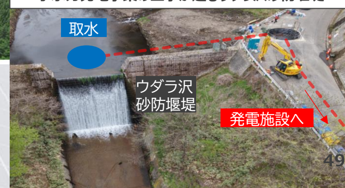
小水力発電事業の工事が進むウダラ沢砂防堰堤
