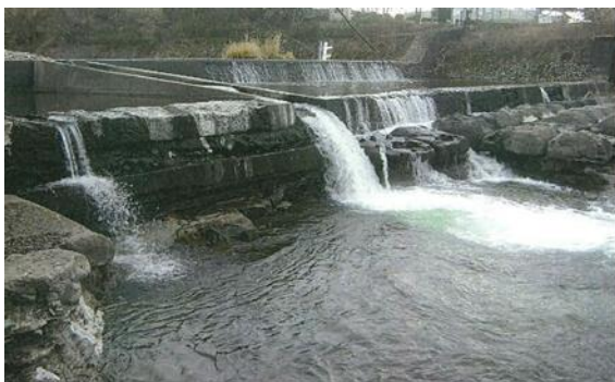
写真3 移動障害のある取水堰
